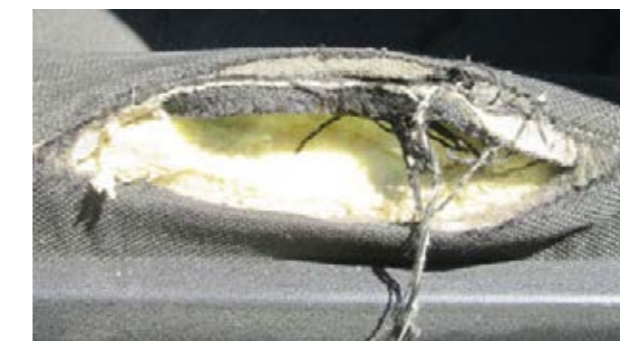
Falta espuma o el marco está roto
