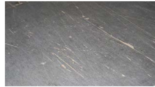
☰ Piso: Ligeras deformación, desgaste superficial
