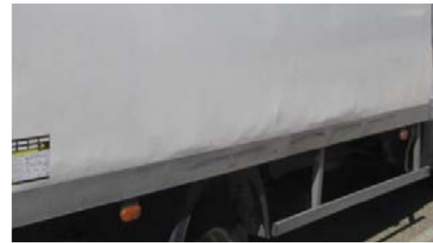
Paneles laterales de fibra: Deformación en la parte inferior, longitud > 1 m Nota: La sustitución del panel frontal de la carrocería inferior requiere el desmontaje de los bajos de la carrocería.
