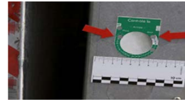
Compuerta de carga: Fechas de control vencidas
