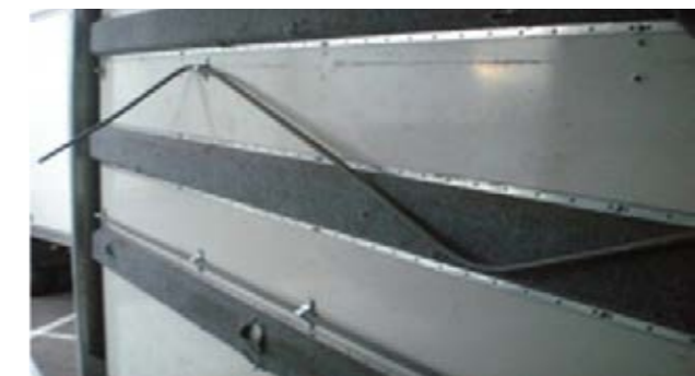
Tapizados y varillas: Varillas, elementos de fijación, faltan los tapizados o se han deformado y no merece la pena repararlos
